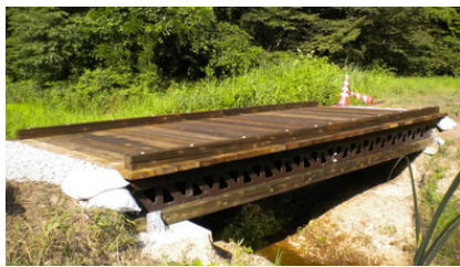
図-1 プレストレス木箱桁橋
