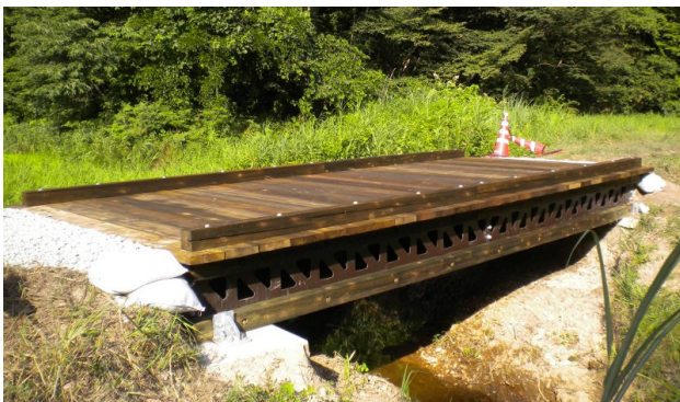
図-1 プレストレス木箱桁橋
