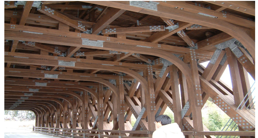
阿蘇望橋の屋根部材
