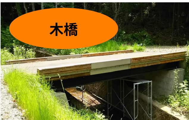
CLT床版橋 (仙北市)
