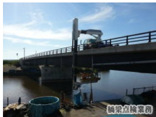
高所作業車を用いた点検 写真：株式会社創研コンサルタント
