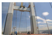
図-2 耐火塗料の塗装
