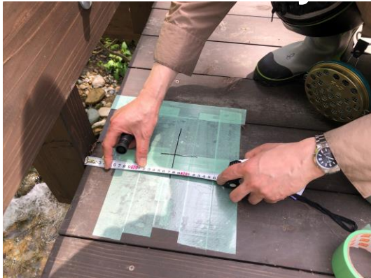
縦桁の真上にタブレットを設置
