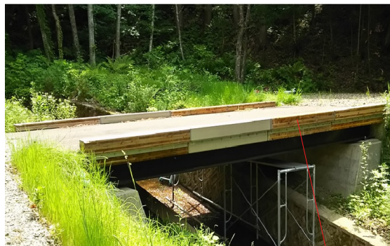
CLT床版橋(仙北市)
