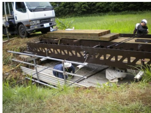
↑ オンサイト木橋施工の様子
