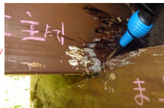
縦桁・枕梁接合部
