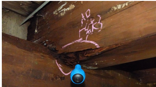
縦桁・枕梁接合部
