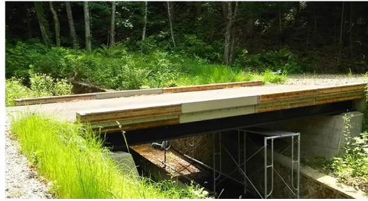
CLT床版橋(仙北市)
