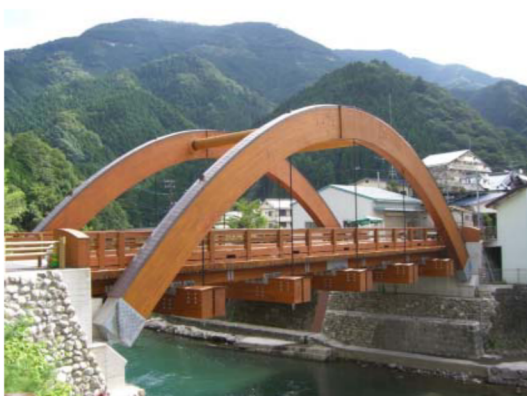
写真-2 対象橋梁全景
