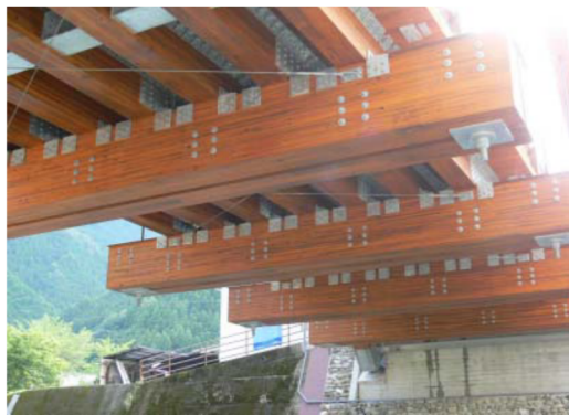
写真-1 床組構造
