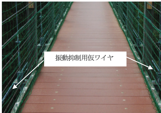
写真-2 振動抑制用仮ワイヤ
