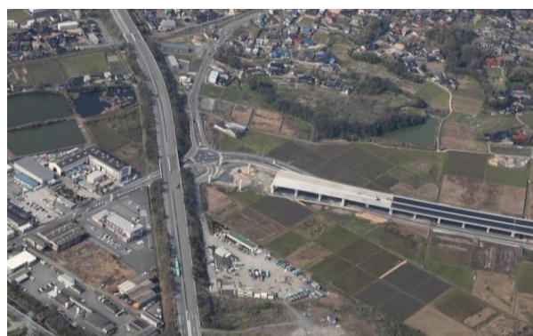
写真-1 宇部興産道路と県道 345 号線の交差部
