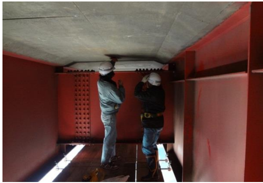
(a) 主桁および床版下面
