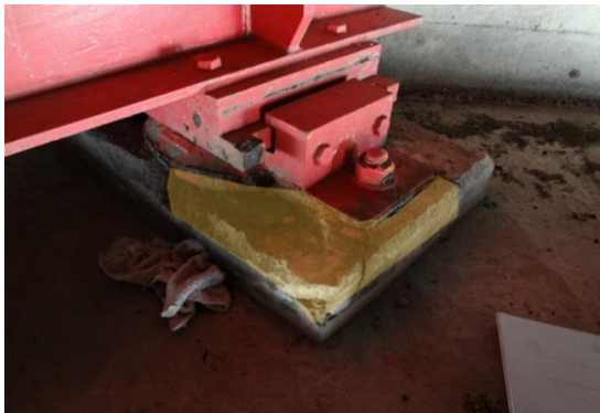
(2) 固定支承 (LG:固定, TR:固定)
