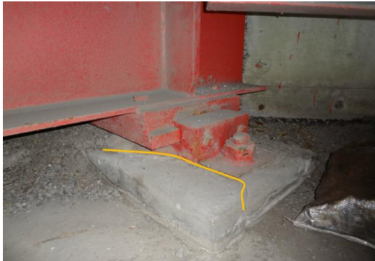
(1) 可動支承 (LG:可動, TR:固定)
