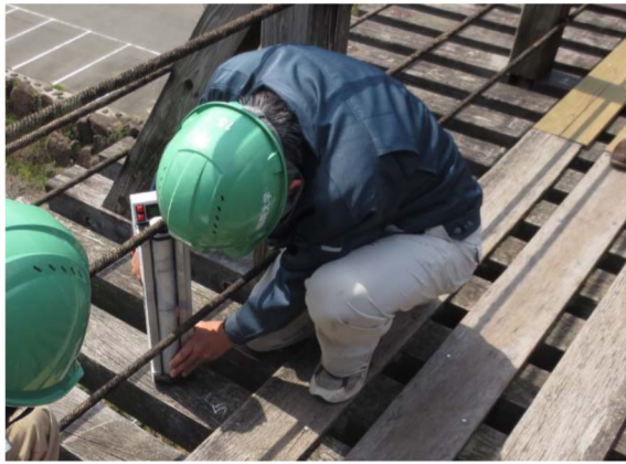
写真-5 穿孔抵抗値の測定の様子
