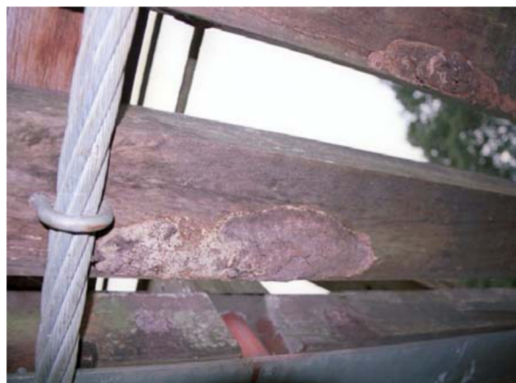
写真-3 下面に付着した子実体（12年目）
