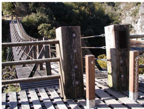
写真-1 調査対象橋の全景（12年目）
