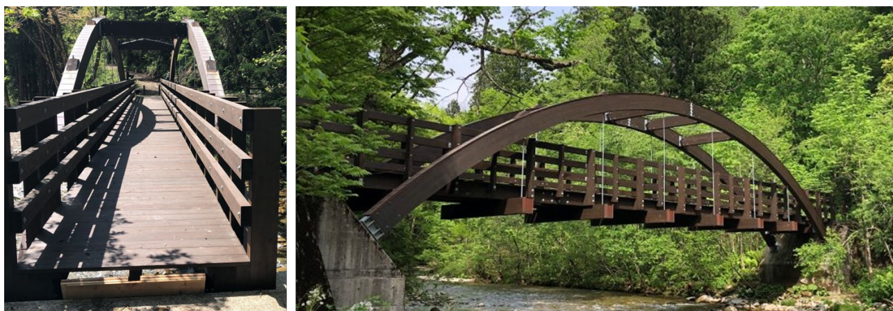
図-2 新橋めもと橋外観
