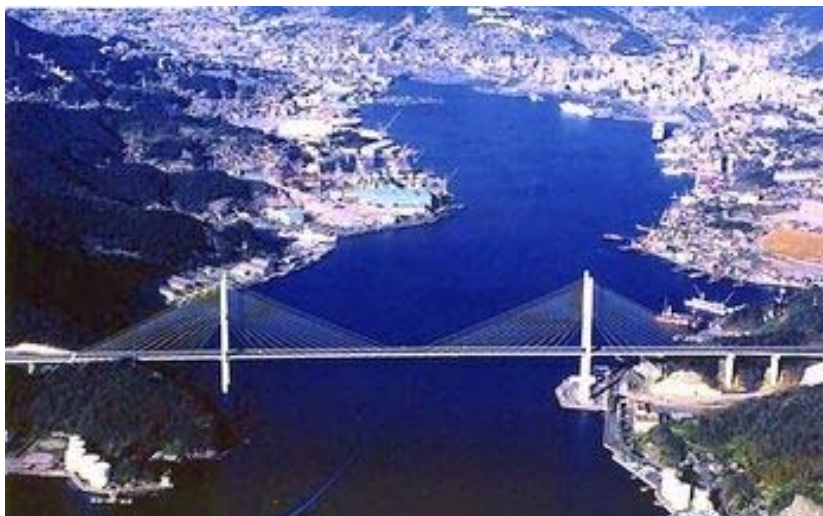
写真-6.2.3 女神大橋 (鋼斜張橋) 5)
