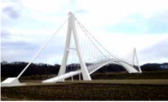
図-1 吊りアーチ橋
