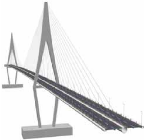
図-2 CFTを用いた斜張橋
