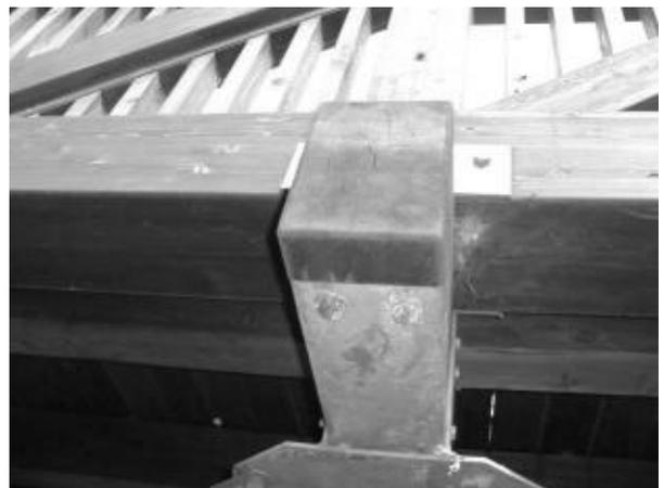
（定期的な点検ポイント） 床組みストラット部材の金具腐食
