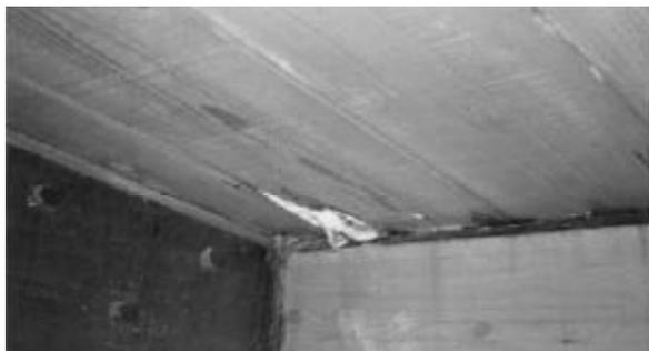
写真 - 5 白色腐朽菌類の子実体
