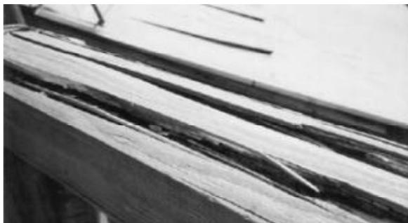
写真 4 高欄の腐朽
