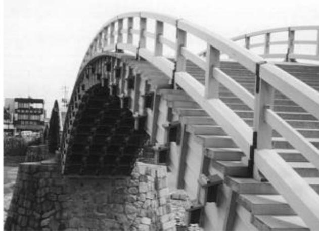
写真 - 解 7.3.2 水処理を施した屋根の無い橋の一例（錦帯橋、山口県岩国市）
