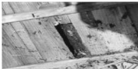
集成材の床板のラミナ1層目までが、腐朽していた状況。
