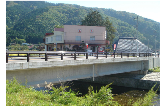
コンクリート橋
