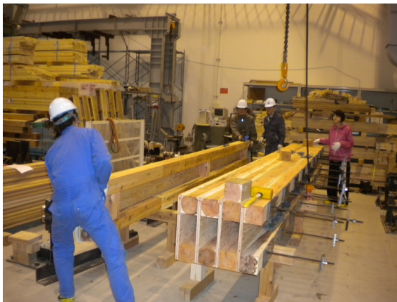
図3 応急橋の組立を行う学生たち
