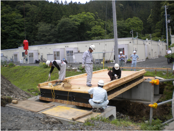
図2 大槌町架設住宅前へのオンサイト木橋の架設
