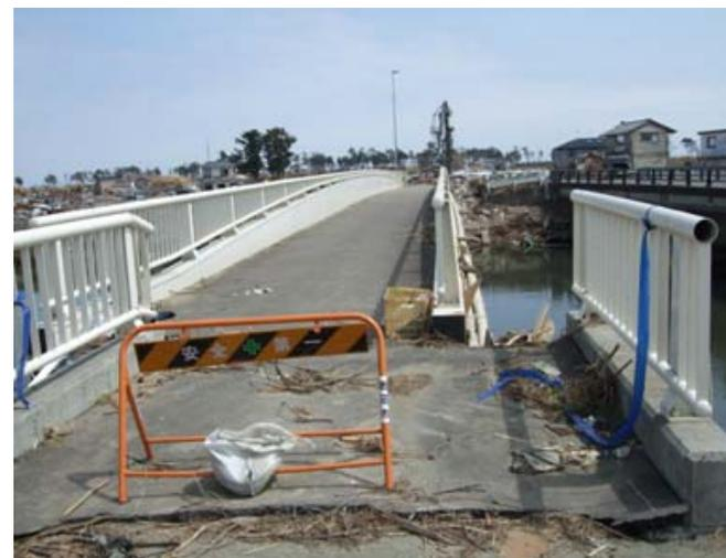
相野釜歩道橋は左岸側が下流に50cm程度ずれている。
