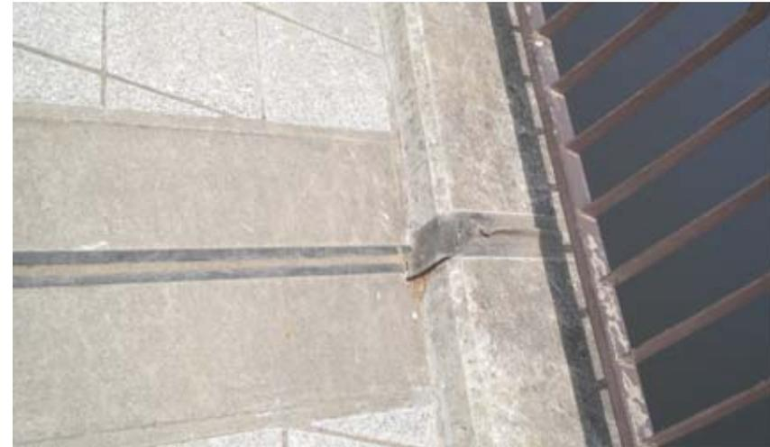
中間支点の継ぎ手部分(歩道側)が少しずれている
