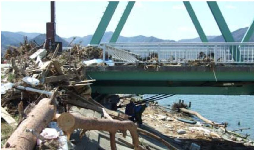
右岸橋台部:落橋防止装置は生きている。
