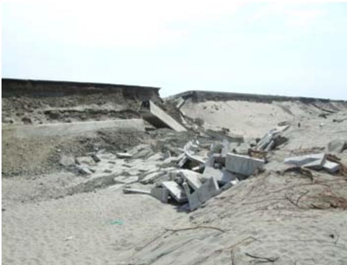
堤の崩壊部分。洗掘されて崩壊したのか？
