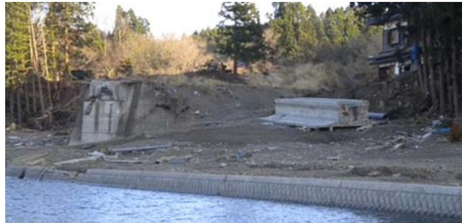
裏込めの盛土は崩壊。橋台がわずかに残っている。
