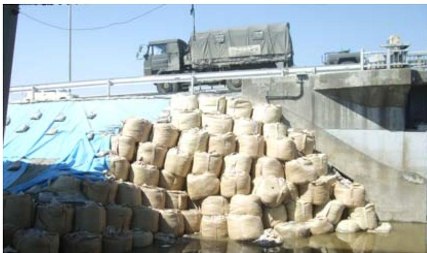
右岸橋台裏の盛り土が崩壊。応急復旧済み。
