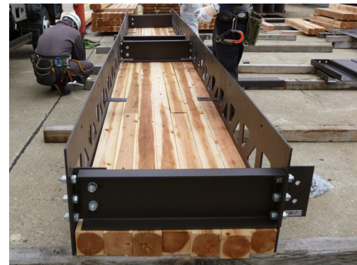
図-9 組立中のプレストレス木箱桁橋の対傾構
