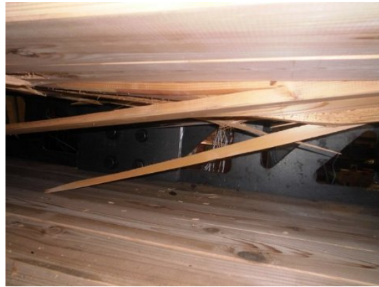
上段木材が引張破壊
