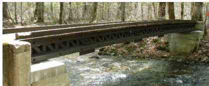
図-1 プレストレス木箱桁橋
