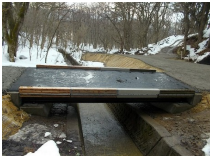
田沢湖 CLT床版橋
