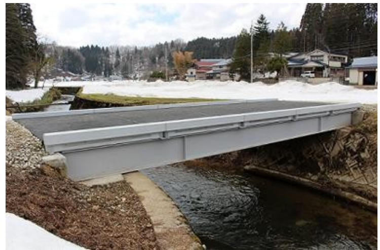
西仙北 CLT床版橋
