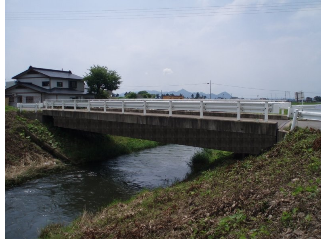
鋼橋に貼り付け
