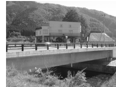
図-3 コンクリート橋
