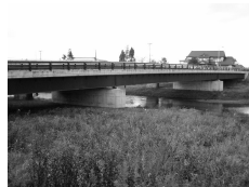
図-2 耐候性鋼橋
