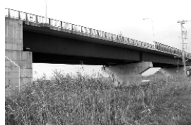
図-2 無塗装耐候性橋梁
