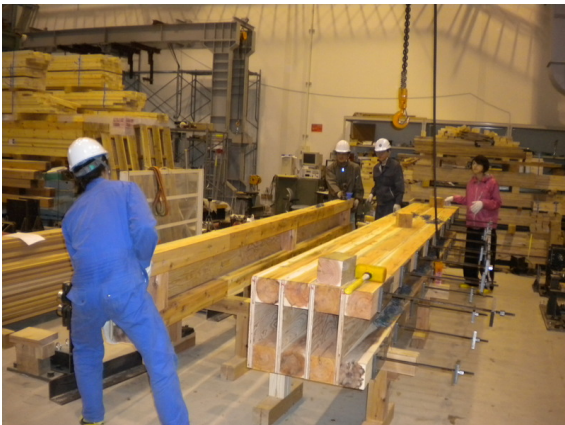
図2 応急橋の組立を行う学生たち
